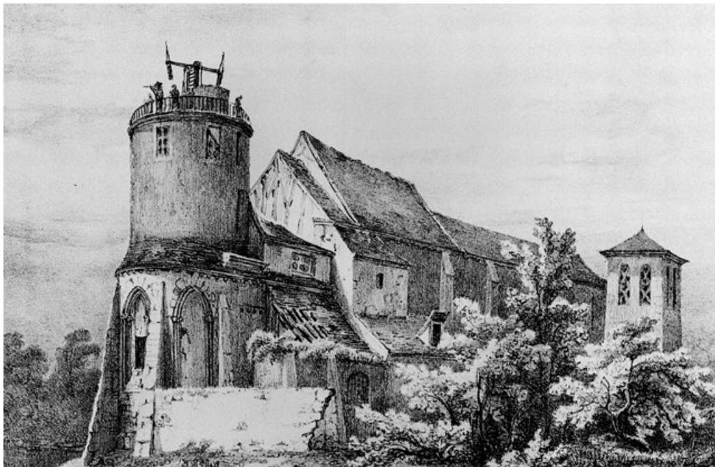
Le télégraphe optique de Chappe à Montmartre installé sur le chevet de l'église Saint-Pierre, à Paris, en 1824.
