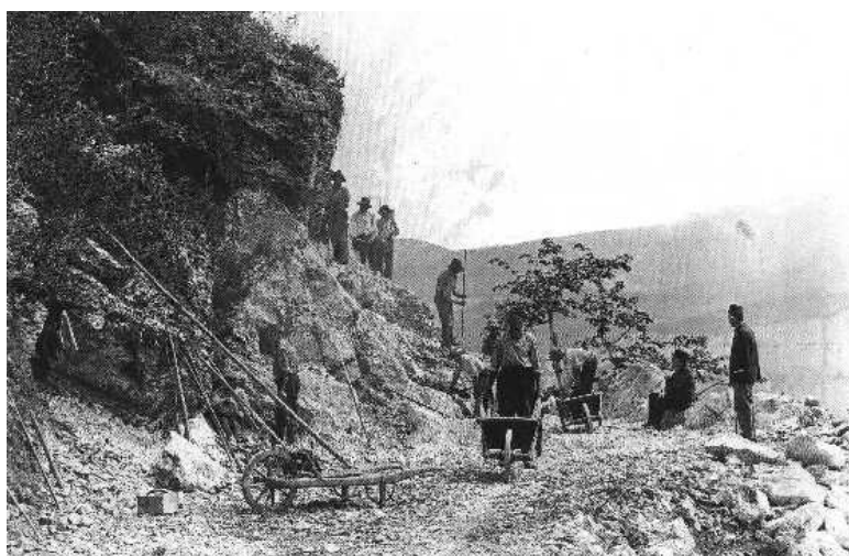
Construction d'une route dans le Vercors
