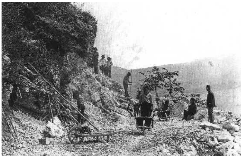
Construction d'une route dans le Vercors
